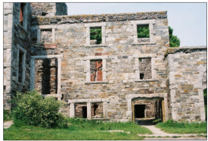
B EXTERIOR ELEVATION PHOTO SCALE: N.T.S.
