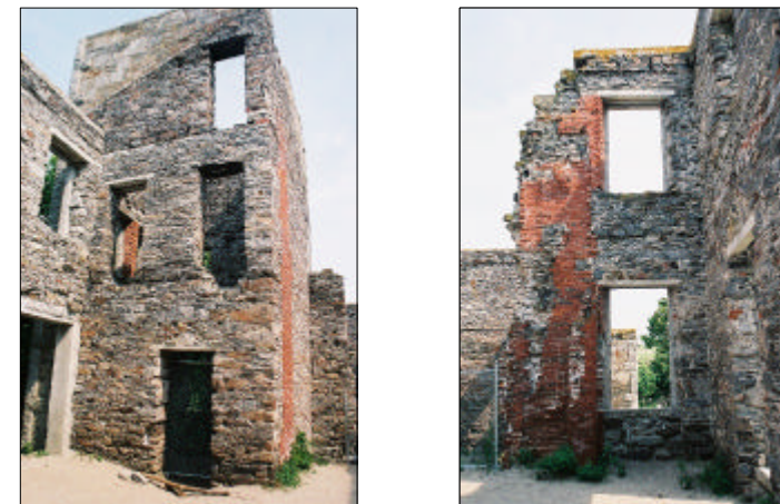
J L INTERIOR ELEVATION PHOTOS SCALE: N.T.S.
