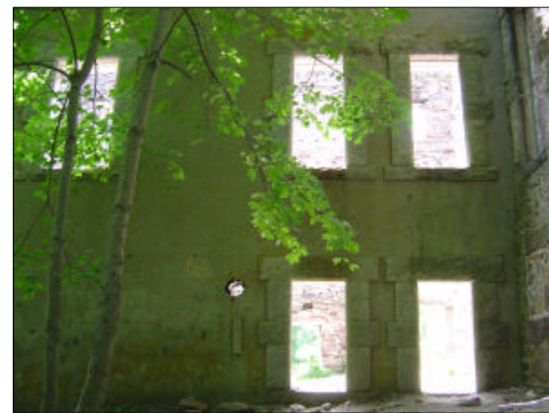
G EXTERIOR ELEVATION PHOTO SCALE: N.T.S.
