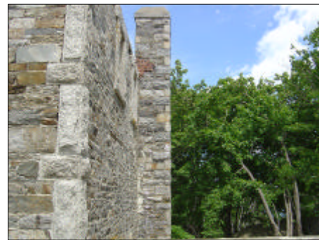
(W) EXTERIOR ELEVATION PHOTO SCALE: N.T.S.
