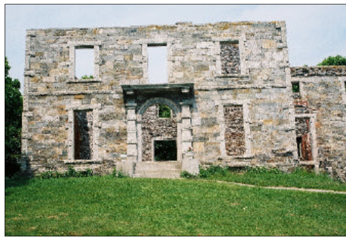
C EXTERIOR ELEVATION PHOTO SCALE: N.T.S.
