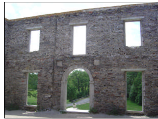
C INTERIOR ELEVATION PHOTO SCALE: N.T.S.
