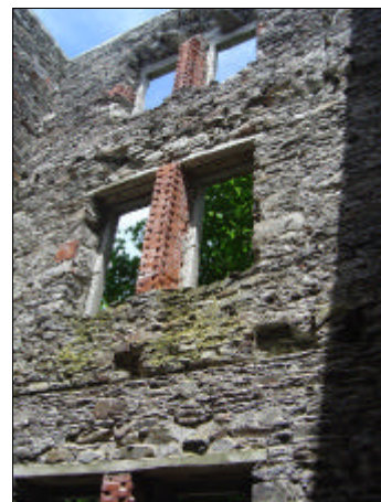
H INTERIOR ELEVATION PHOTO SCALE: N.T.S.
