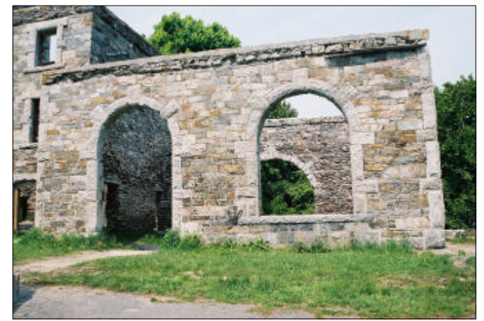
A EXTERIOR ELEVATION PHOTO SCALE: N.T.S.
