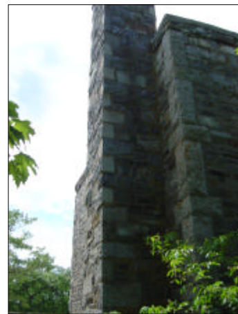
(X) EXTERIOR ELEVATION PHOTO SCALE: N.T.S.
