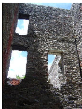
(N) INTERIOR ELEVATION PHOTO SCALE: N.T.S.
