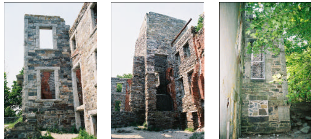
M INTERIOR ELEVATION PHOTOS SCALE: N.T.S.
